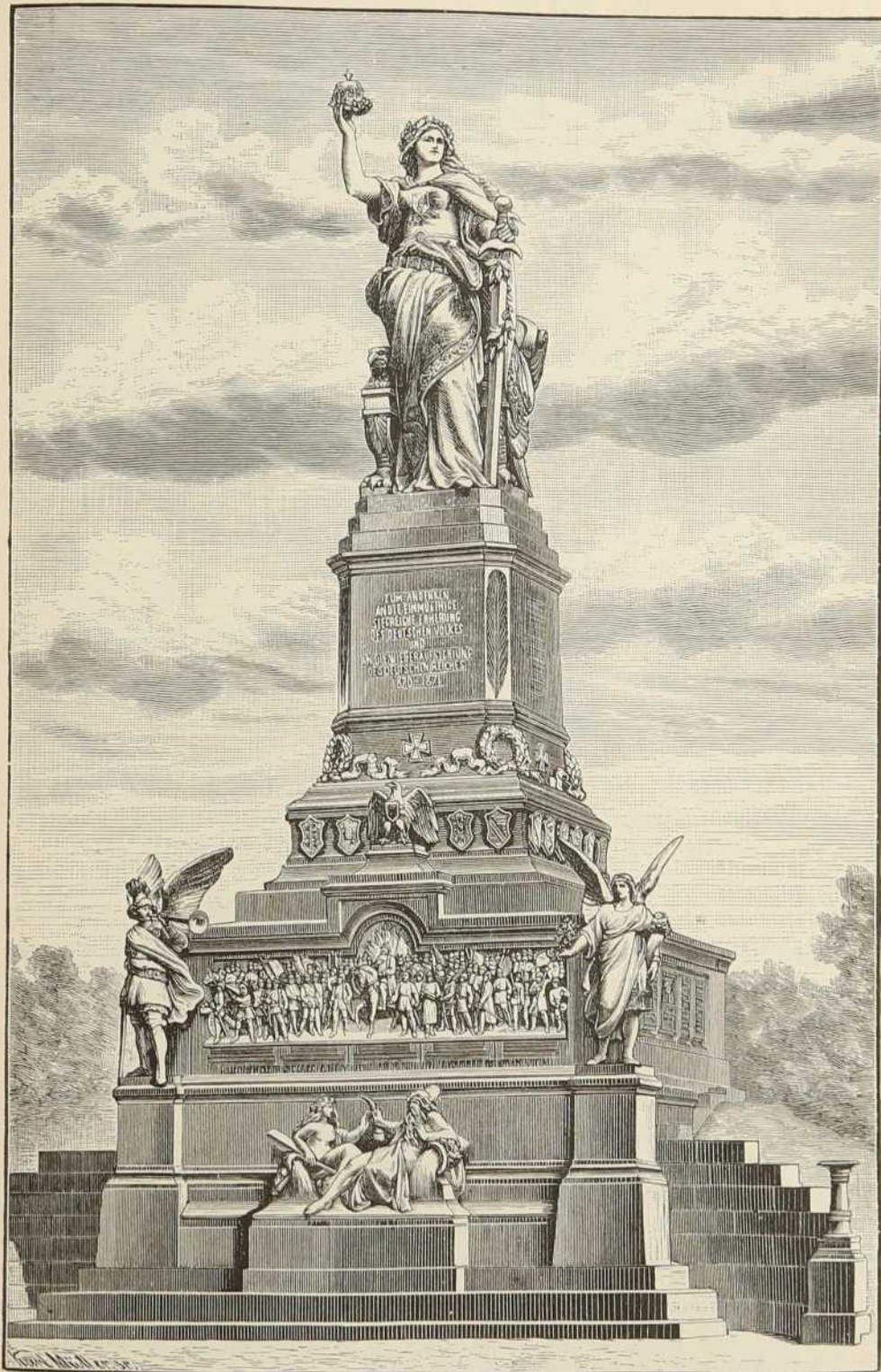
Das Nationaldenkmal auf dem Niederwald.
