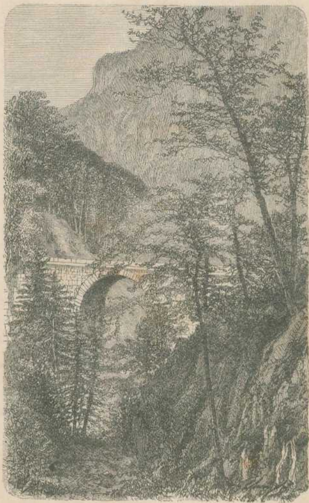
Brücke über den Güters. (S. 165.)
