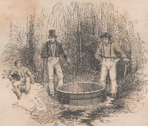
„Mit der Tonne wird ein Brunnen angelegt.“
